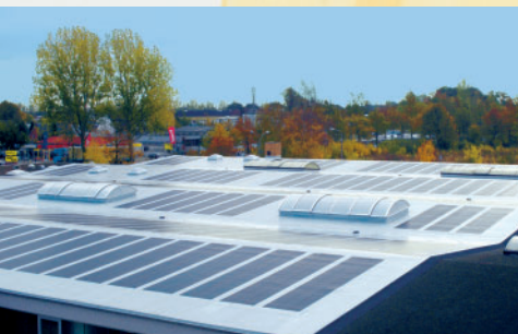
Usine HASECO Zöger, ▲ Bremen: 71,4 kW c
