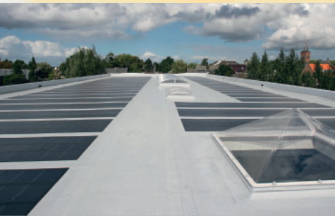
Bâtiment d'Entreprise WEMMERS, ▲ Bleskensgraaf, NL: 18,4 kW c
