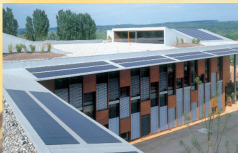
Complexe scolaire, ▲ Remerschen, Luxembourg: 27,6 kW c
