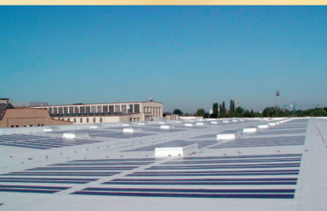
Dépôt de tramways, ▲ Nürnberg: 90,1 kW c
